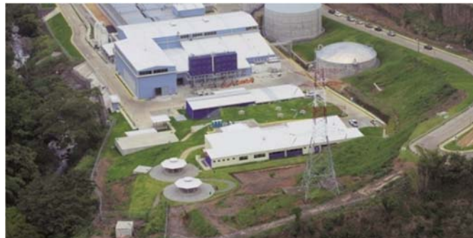
Planta de Tratamiento de Aguas Residuales Los Tajos.
